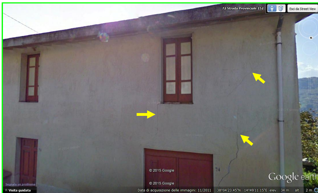
Foto 10 - S.P. 152 Km 2+260 (Sud C.da Sirico) – Sito d'attenzione SA-016I-5CU-001 Fabbricato con evidenti segni di dissesto - Immagine ripresa da Google Earth
