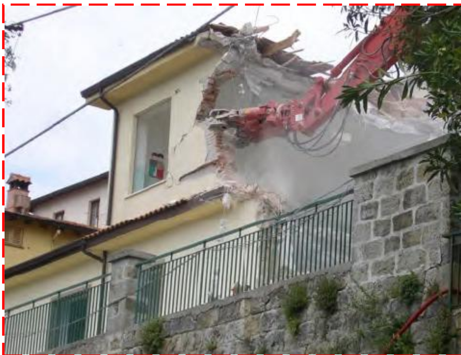
Foto 3 - Sfaranda – Dissesto 016I-5CU-005 Lavori di demolizione dell'edificio scolastico
