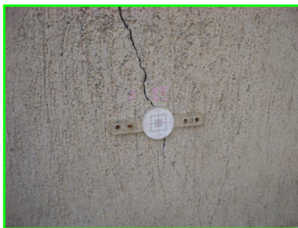
Foto 11 - S.P. 152 Km 2+260 (Sud C.da Sirico) Sito d'attenzione SA-016I-5CU-001 Particolare del fessurimetro posto sul prospetto principale del fabbricato
