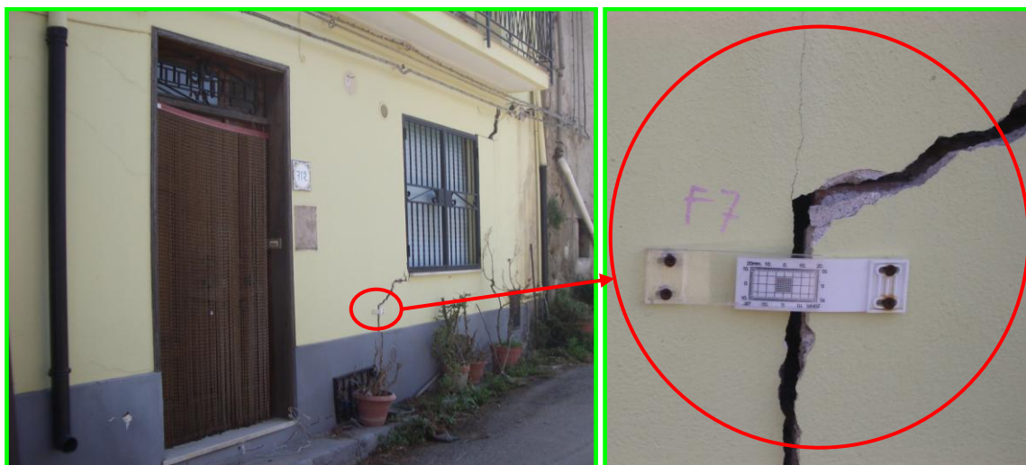
Foto 8 - Sfaranda – Dissesto 016I-5CU-005 Edificio fortemente danneggiato e monitoraggio con fessurimetro
