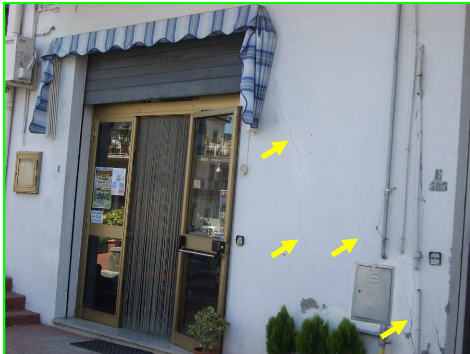
Foto 9 - Sfaranda – Dissesto 016I-5CU-005 (Porzione più occidentale) Fabbricati con evidenti segni di dissesto lungo la S.P.153
