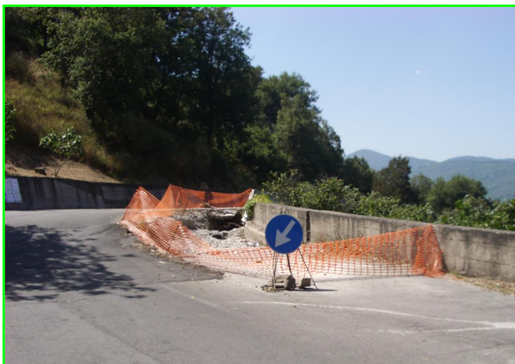
Foto 10 - S.P. 152 Km 2+450 (Sud C.da Sirico) – Dissesto 016I-5CU-038 Cedimento della carreggiata con dislivello
