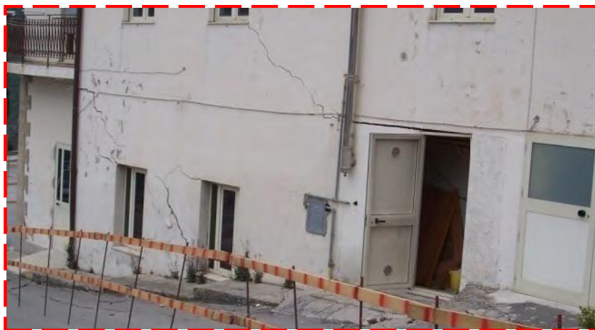
Foto 5 - Sfaranda – Dissesto 016I-5CU-005 Edificio fortemente danneggiato
